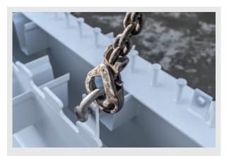
HENSOTHERM® 2K-Systeme werden in der Werkstatt appliziert und sind bereits nach 24 Stunden Trocknungszeit bestens geschützt gegen mechanische Belastungen und Witterungseinflüsse. So können bereits beschichtete Stahlelemente im Außenbereich gelagert und/oder zeitsparend direkt zum Einsatzort transportiert und dort montiert werden.
