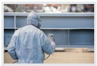
Ein 2K-System für Feuerwiderstandszeiten von R30/60/90/120: Schnelleres Beschichten, da kein Systemwechsel nötig. Korrosivitätskategorien von bis zu C5 hoch im System möglich. Die optimal eingestellte (längere) Topfzeit macht die Verarbeitung auch mit geeigneten 1K-Anlagen möglich.
